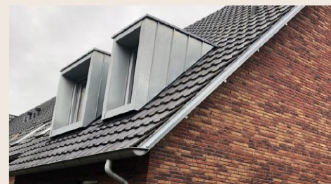
Groot Holthuizen - goede nestplaatsen onder de dakpannen (geen kantpan maar strip)
