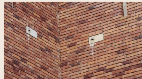
Haverleij - de nestkasten in de gevels van het kasteel, bewoond door spreeuw
