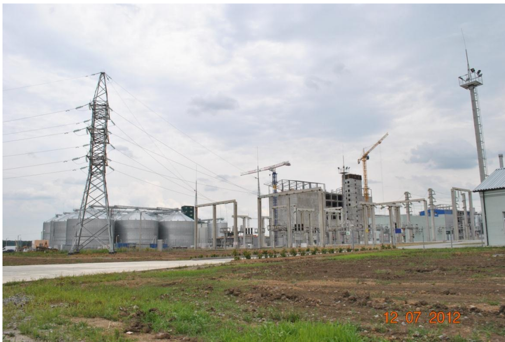
Foto 3 Een deel van het bedrijf in aanbouw
